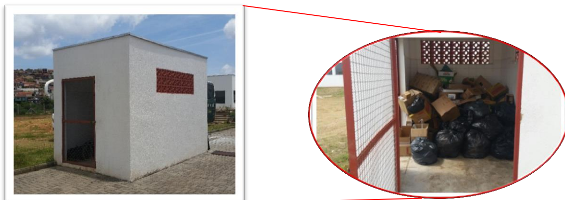
Figura 32 - Local de armazenamento temporário dos resíduos sólidos recicláveis
